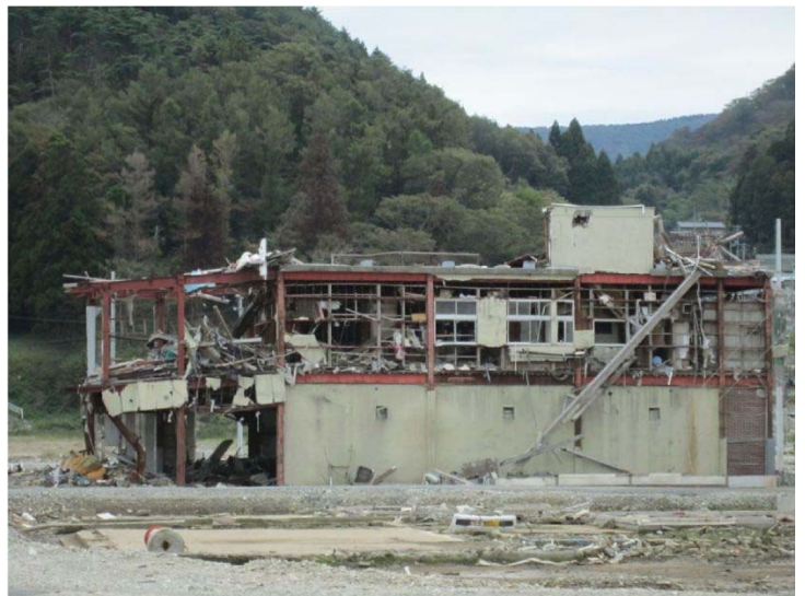
図 10 上：鮫浦集落の惨状、 中：女川町倒壊ビル、 下：女川町被災ビル
