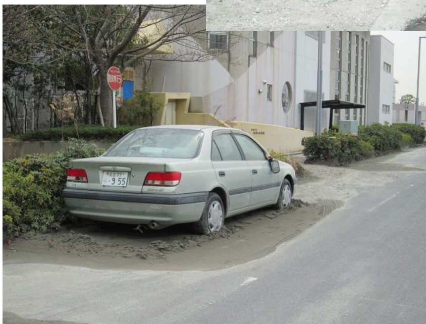
図 17 上：新浦安駅前 EV、 中：浮上したマンホール、 下：液状化の砂に埋まる車
