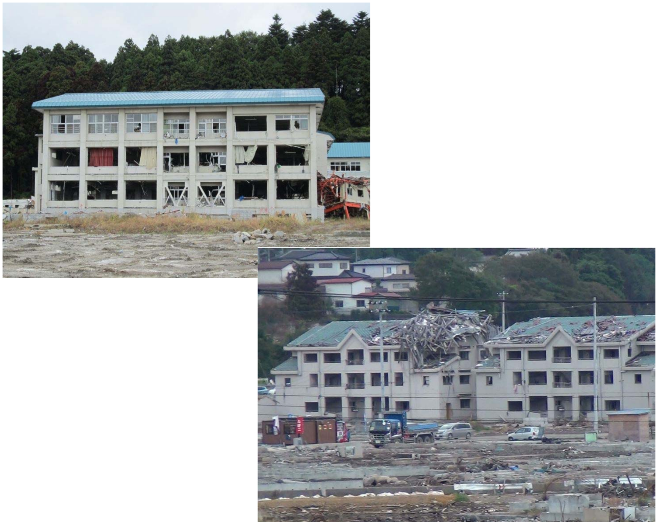
図 5 津波の爪痕(上：陸前高田高校、下：女川町住宅)
