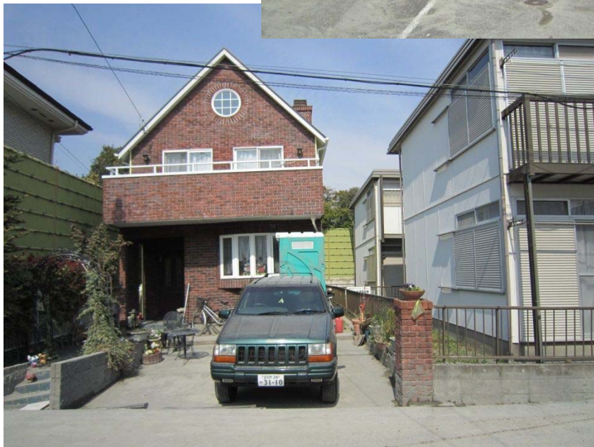
図 18 上：今川地区、 中：ベランダが落ちたマン ション、 下：傾いた家
